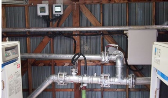
例 1 : バイパス管を製作して各種センサを設置
