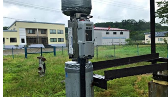
例 2 : 配管を切断せずに流量計を設置 (断熱材のみカット)
