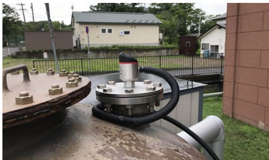
例 5 : 貯湯タンクに設置したレベル計
